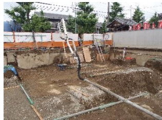
掘削作業終了後の風景
