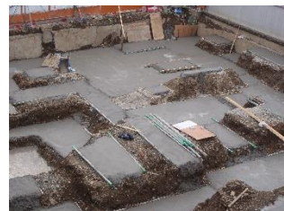
捨コン打設後の風景
