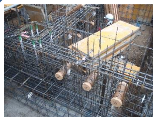
基礎・地中梁配筋作業④
