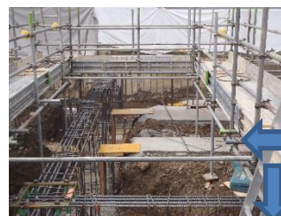
基礎・地中梁配筋作業①
