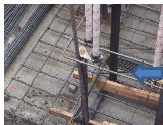
基礎・地中梁配筋作業②
