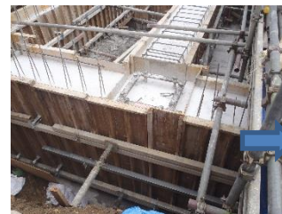
型枠建入、コンクリート流し込み
