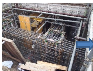
基礎・地中梁配筋作業⑤
